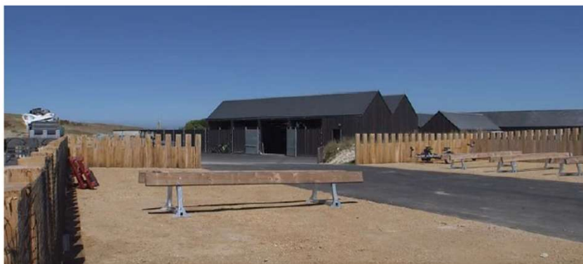
Secteur de la gare maritime et déchetterie de Hoëdic
